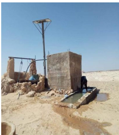
Photo N° 15. Puits équipé de panneaux solaires (Zone de Elmussagam- El-Maaeder )
